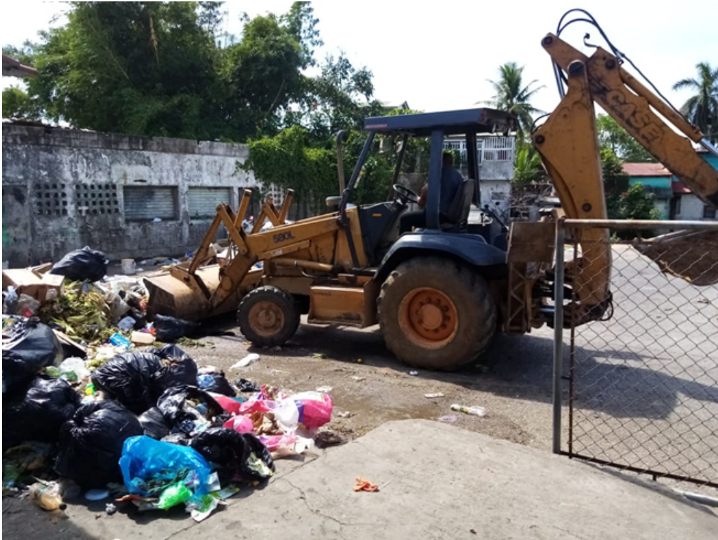
Fotografía No 1: Retiro de los desechos del botadero clandestino
