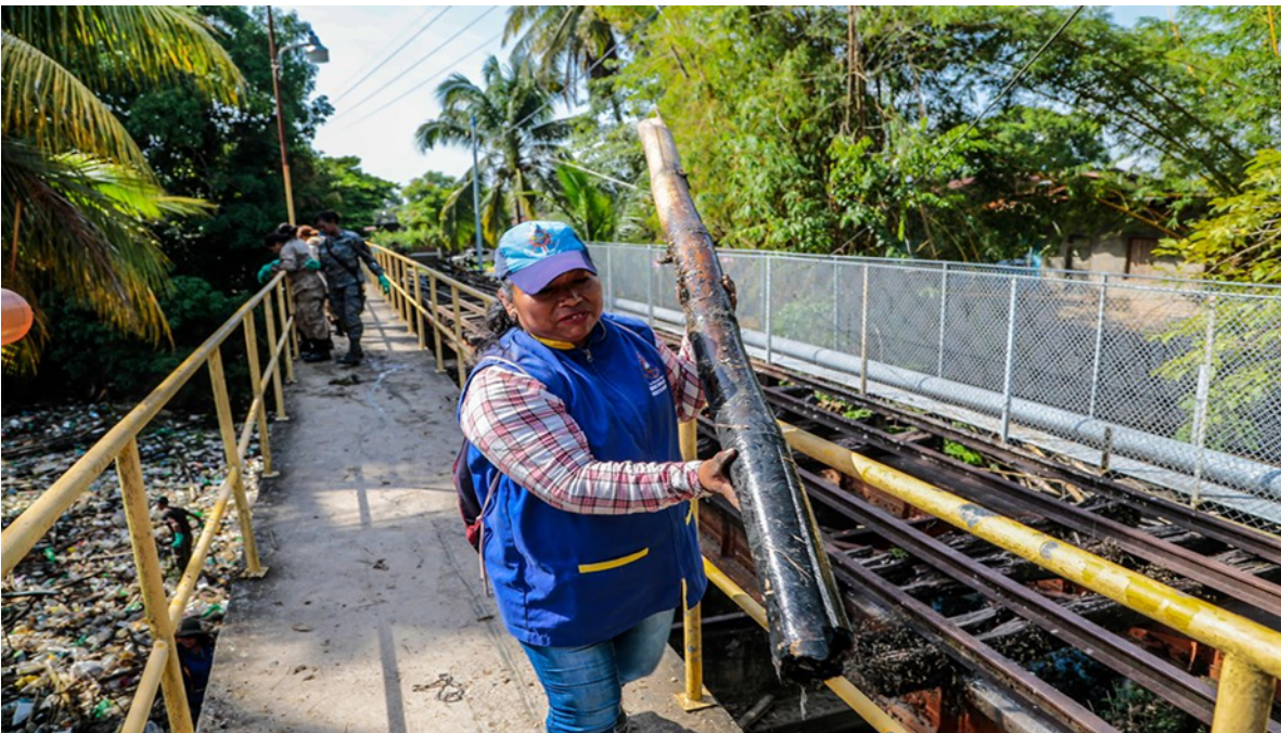
Fotografía No 6: Retiro de material sintético por parte de personal municipal, apoyado por los Infantes de Marina
