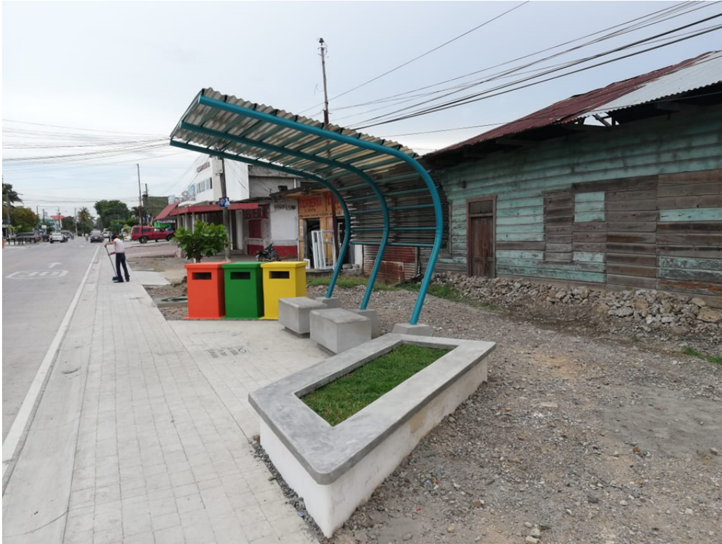
Fotografía No 15: Depósitos de desechos sólidos separativos e identificados con colores en una nueva parada de bus
